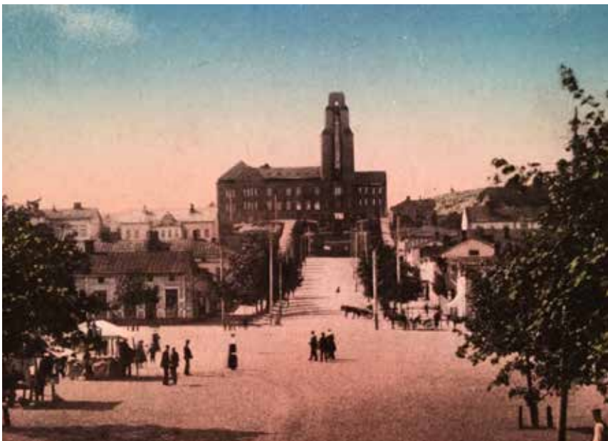
Kaupungintalo kohosi valmistuttuaan seremonia-akselin eteläpäädyssä komeana rakennuksena. Näkymä torilta katsottuna vuoden 1915 vaiheilla. (Kuva: Lahden kaup.museon kuva-arkisto, postikortti)
